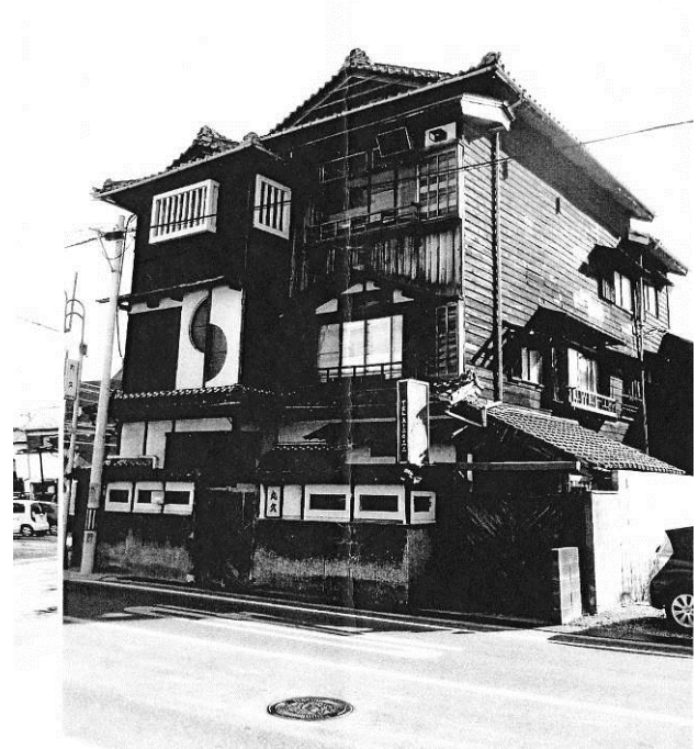
▲ 解体前の「丸久」旅館 2014. 8. 13撮影
